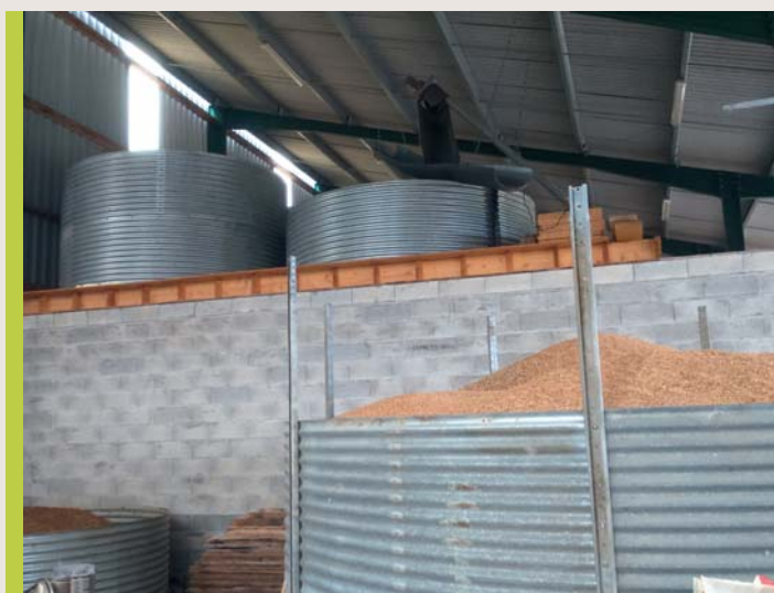
Silos en cours de remplissage - Domaine Saint Pierre (11)
