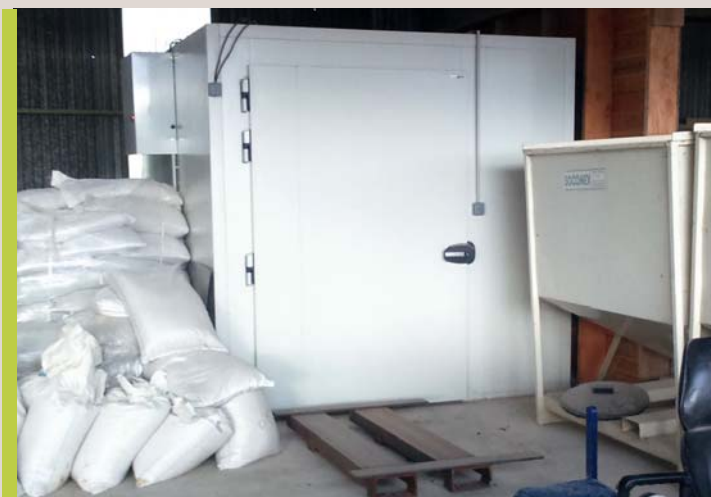
Passage en chambre froide (2-3°C) de tous les lots de grains Ferme des Terres de Solan (09)
